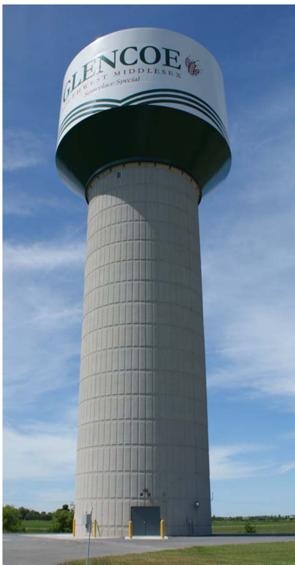
Figure : Réservoir d'eau de Glencoe, réseau d'approvisionnement de Southwest Middlesex
